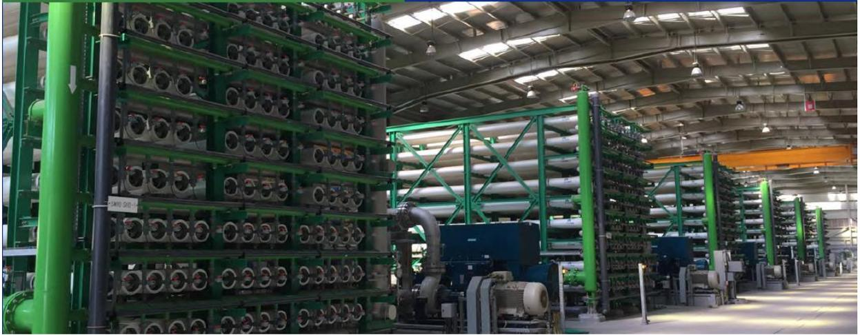
阿奎特公司开发的 LoWatt® 海水淡化技术主要集中在膜法海水淡化的两大痛点：生物结垢和能源消耗。LoWatt®工艺结合了强大的预处理、优化的反渗透设计和专有的清洗机制，以提供最低成本的脱盐淡水。LoWatt®专利工艺降低了能源消耗，使客户的水成本降到最低。
